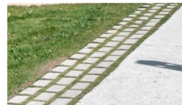
Pavés à joints larges végétalisés
