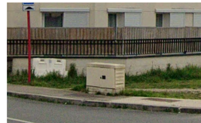
Figure 38 : Armoire télécom existante rue Elie Lourmet
