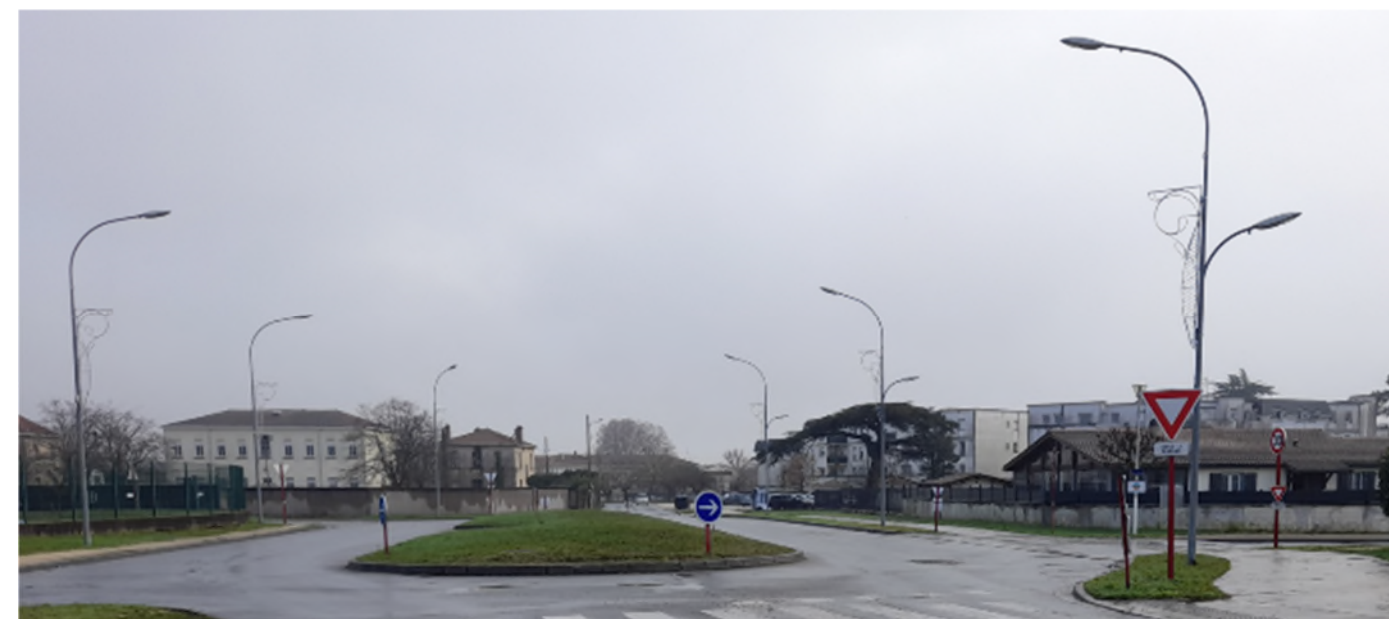
Figure 25 : Candélabres d'éclairage public existants
