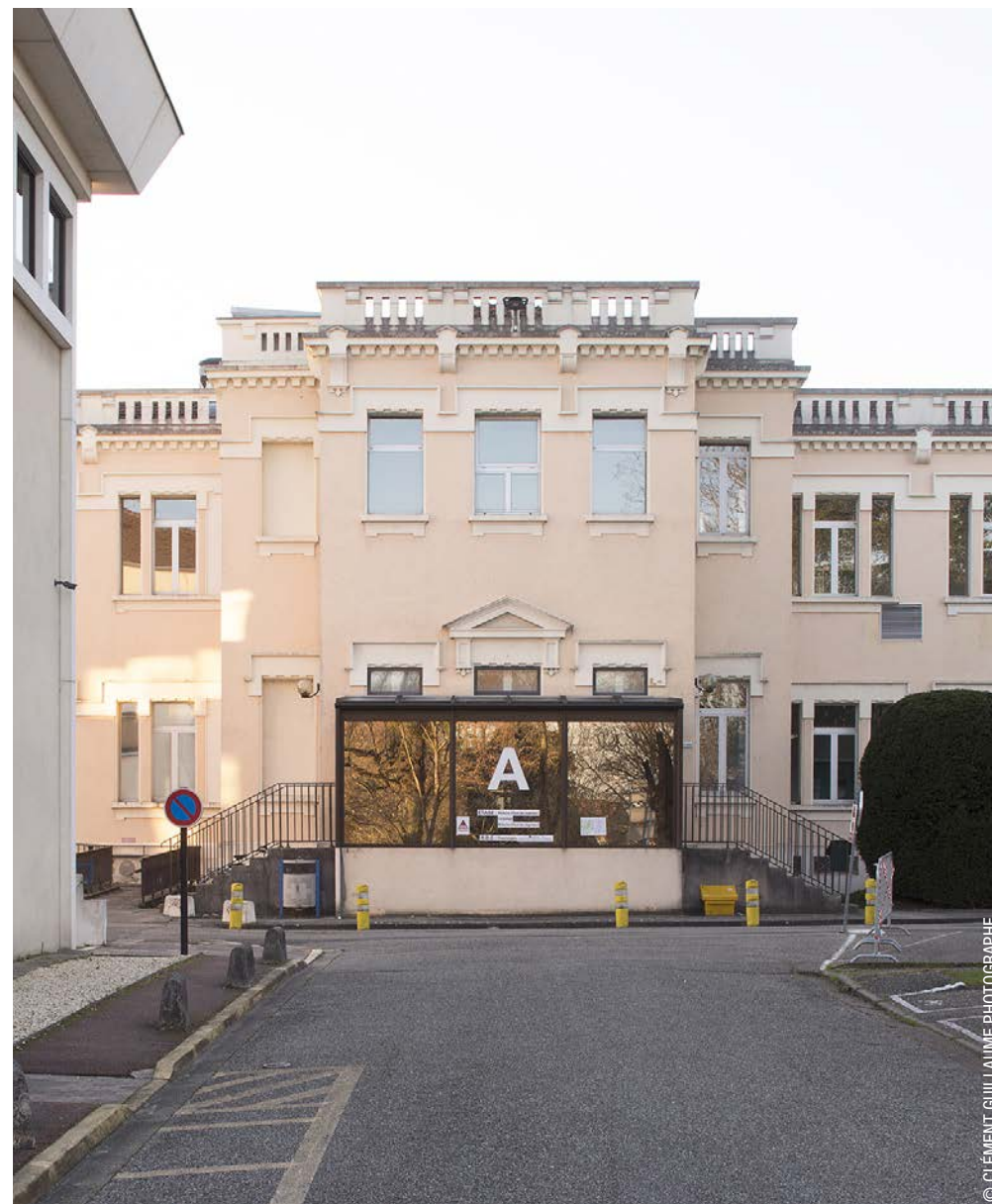
Un des bâtiments du « Peigne » (bat. 063) - construction en 1936
