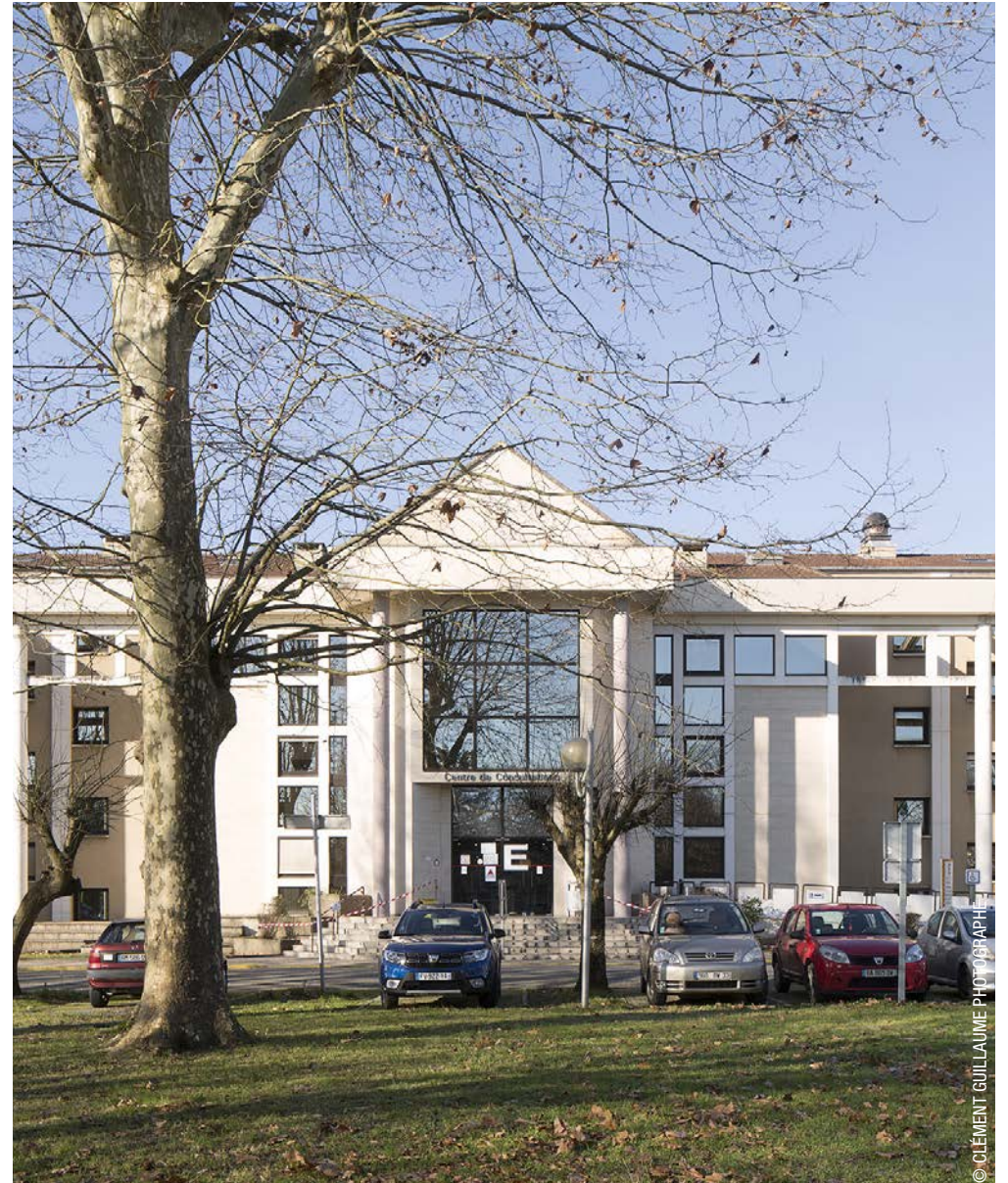
Façade principale du Centre des consultations (bat. 122) - construction en 1990
