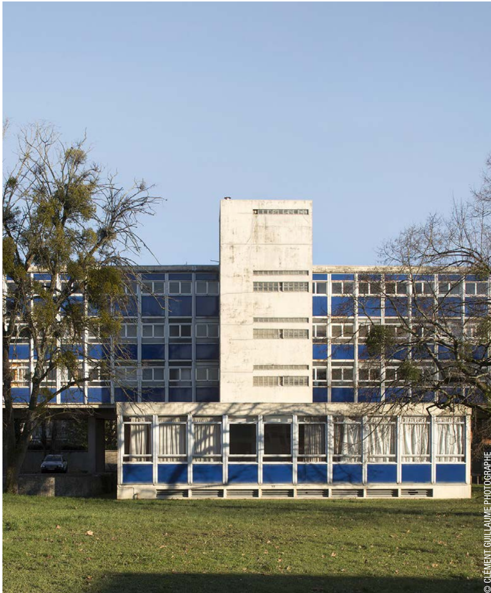
Ancienne école des infirmières (bat. 006) - construction en 1965
