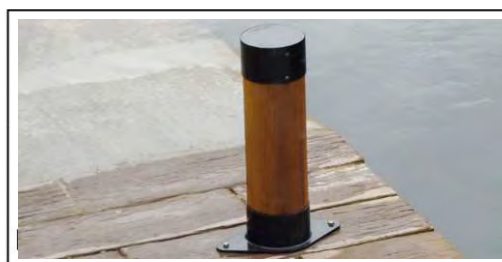
Mise en place de potelets
