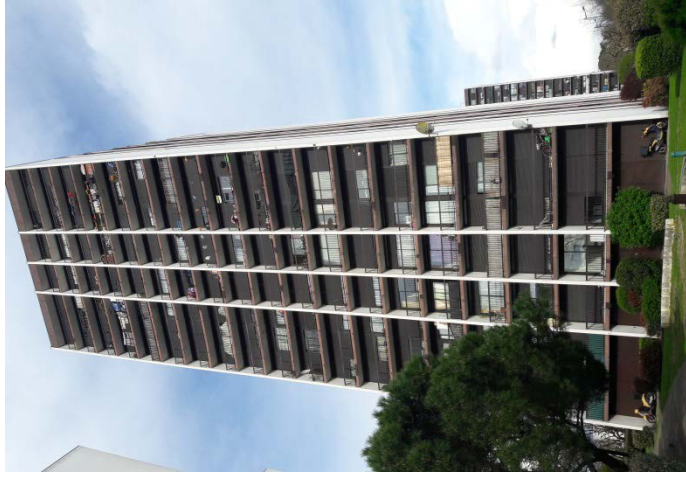
Façade « brune » : volets roulants
