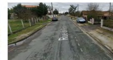
Marquage du stationnement sur voirie en chicane inopérant
