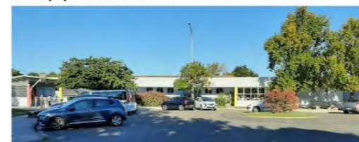
Établissement scolaire de la place de la Résistance
