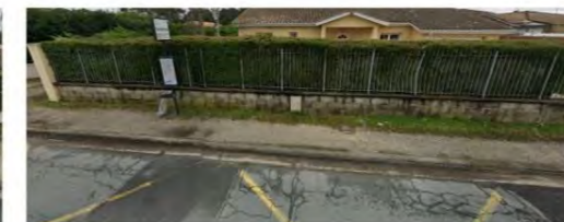
Etat dégradé des quais bus
