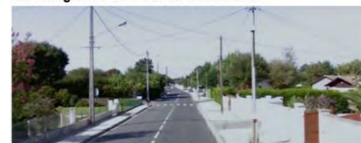
Trottoirs dissymétriques et émergences faisant obstacle aux cheminements piétons
