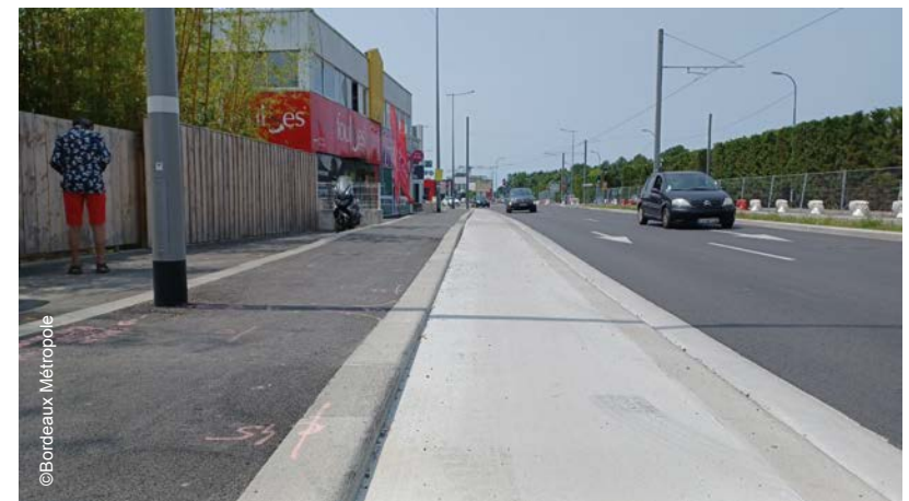
Exemple de piste unidirectionnelle à niveau intermédiaire entre trottoir et chaussée, avenue John Fitzgerald Kennedy, Mérignac
