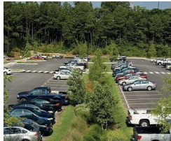
Gestion aérienne des eaux de pluie sur un parking
