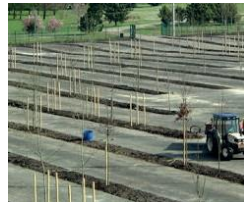
Désimpermeabilisation et plantation des parkings enrobés
