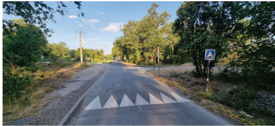
Carrefour Av. de Touban / Av. de Mazeau (état des lieux)
