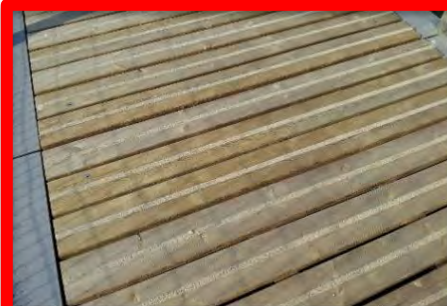
Platelage bois avec incrustation de résine anti-glissance
