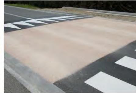
Résine sur voirie
