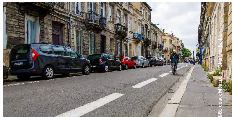
Exemple de bande cyclable et trottoir peu large sur la rue Judaïque
