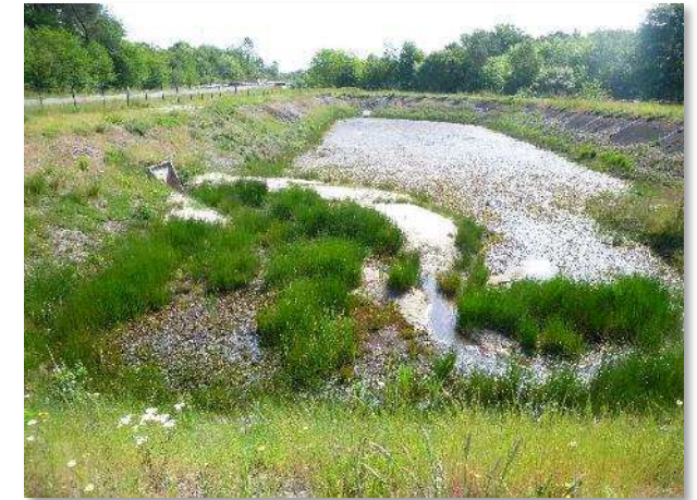
Bassin d'eaux pluviales colonisé par une végétation aquatique et amphibie
