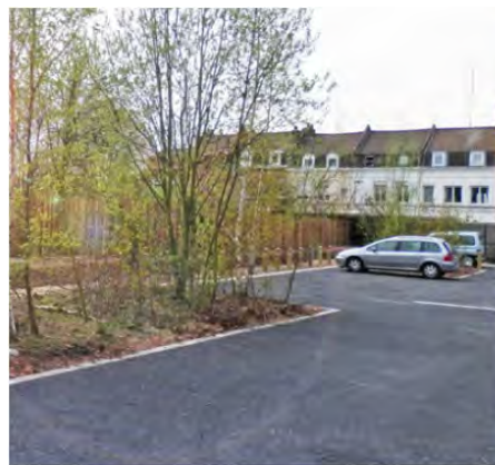
Enrobé sur aire de stationnement
