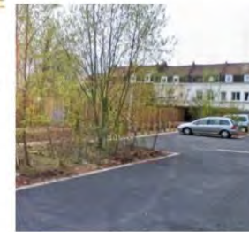
Enrobé sur aire de stationnement
