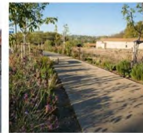
Béton désactivé beige sur cheminement principal pour modes doux
