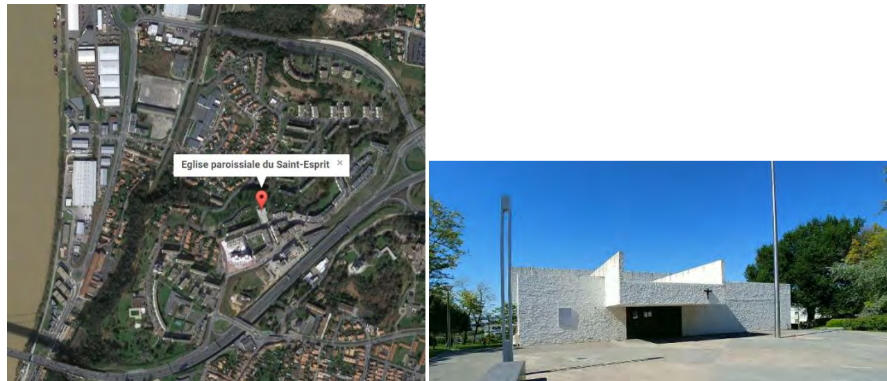
Figure 51 : Eglise paroissiale du Saint-Esprit (source : Monumentum et visite sur site, mai 2021)
