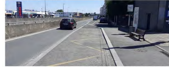
Interruption des pistes cyclables au droit des arrêts de bus
