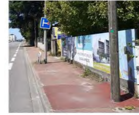
Obstacles à l'accessibilité PMR
