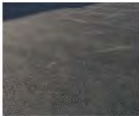
Enrobé classique de voirie et voie cyclable
