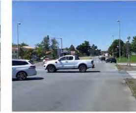
Marquage interrompu en carrefour
