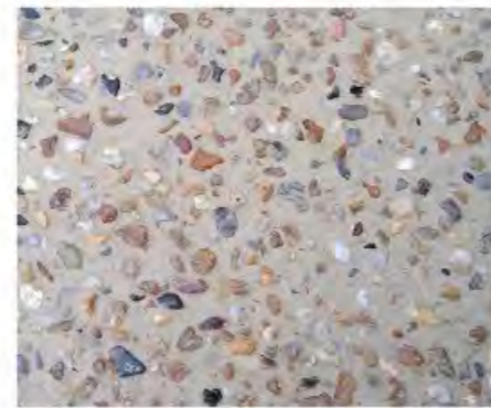
Béton désactivé pour trottoir
