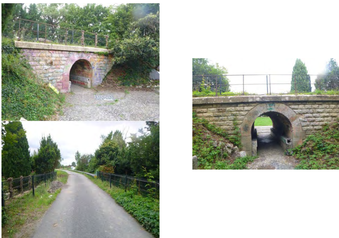
Figure 7 – Photos de l'ouvrage d'art existant
