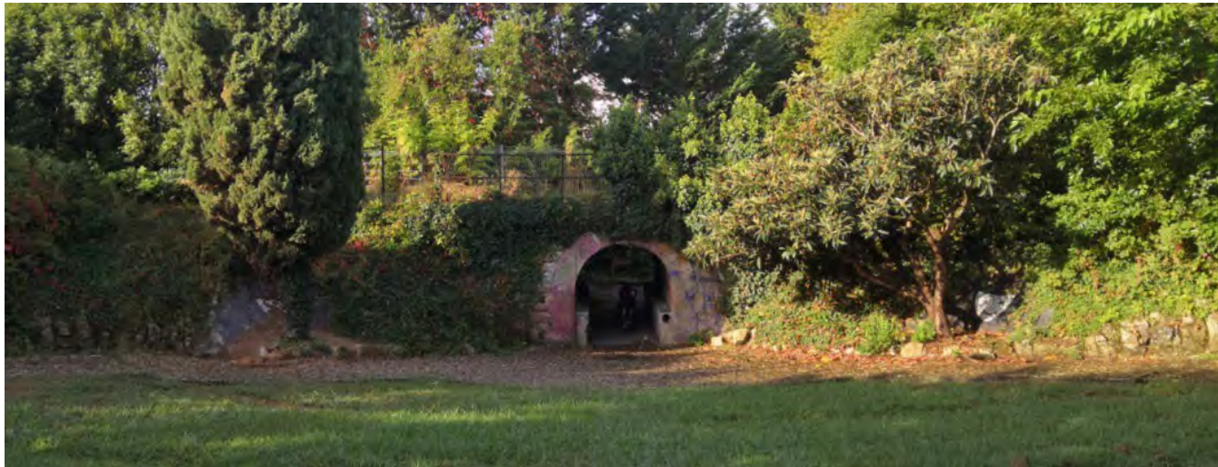
Figure 18 : Passage piéton sous la voie Eymet
