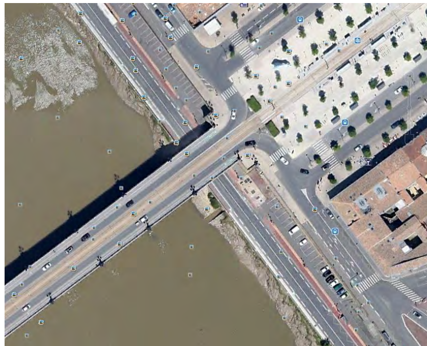
Reprise spontanée de vasière et de gazon amphibie au pied du quai de part et d'autre du pont de pierre
