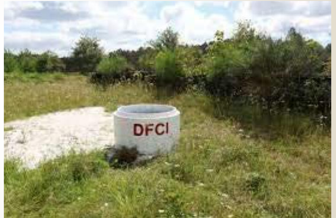
Forage de la Défense de la Forêt Contre l'Incendie, DFCI
