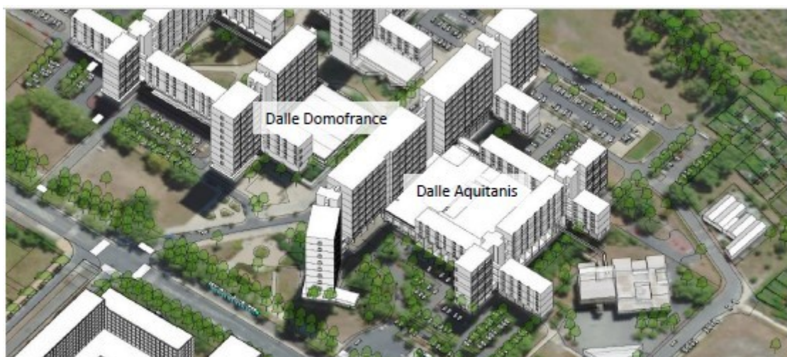
Etat des lieux : les dalles Domofrance et Aquitanis dans la résidence des Aubiers (réalisation : groupement FLINT)
