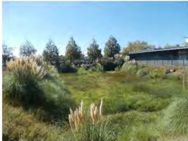
Bassin de récupération des eaux pluviales 07/09/18 – SEGED (ALEZIER S.)
