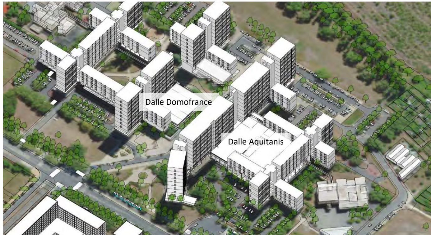
Etat des lieux : les dalles Domofrance et Aquitanis dans la résidence des Aubiers (réalisation : groupement FLINT)
