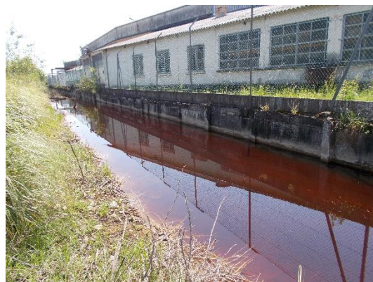
Fossé rejet des eaux industrielles (friche Cracovie) 22/05/18 – SEGED (ALEZIER S.)
