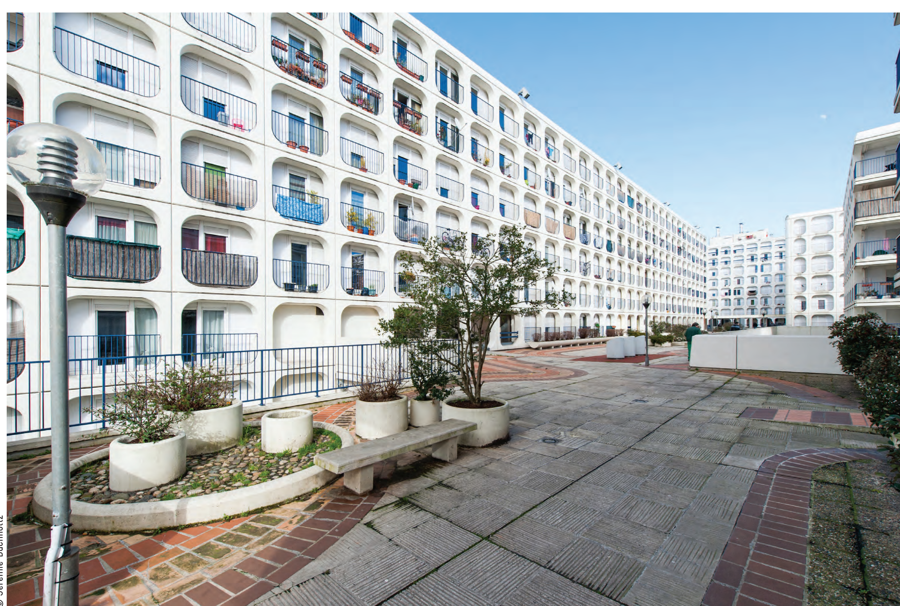
Des espaces résidentiels à aménager (ici la résidence du Lac)
