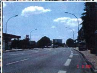
Boulevard Antoine Gautier Largeur de la rue environ 34 m
