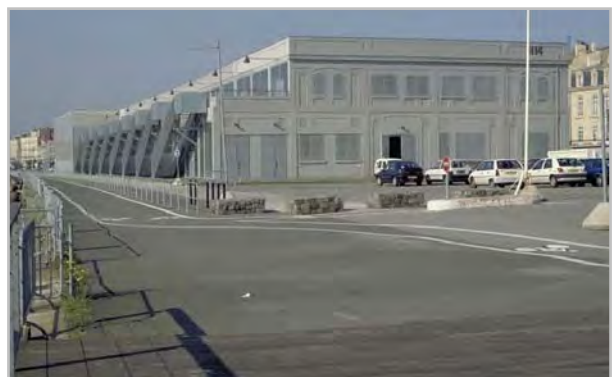
Les hangars - Bordeaux
