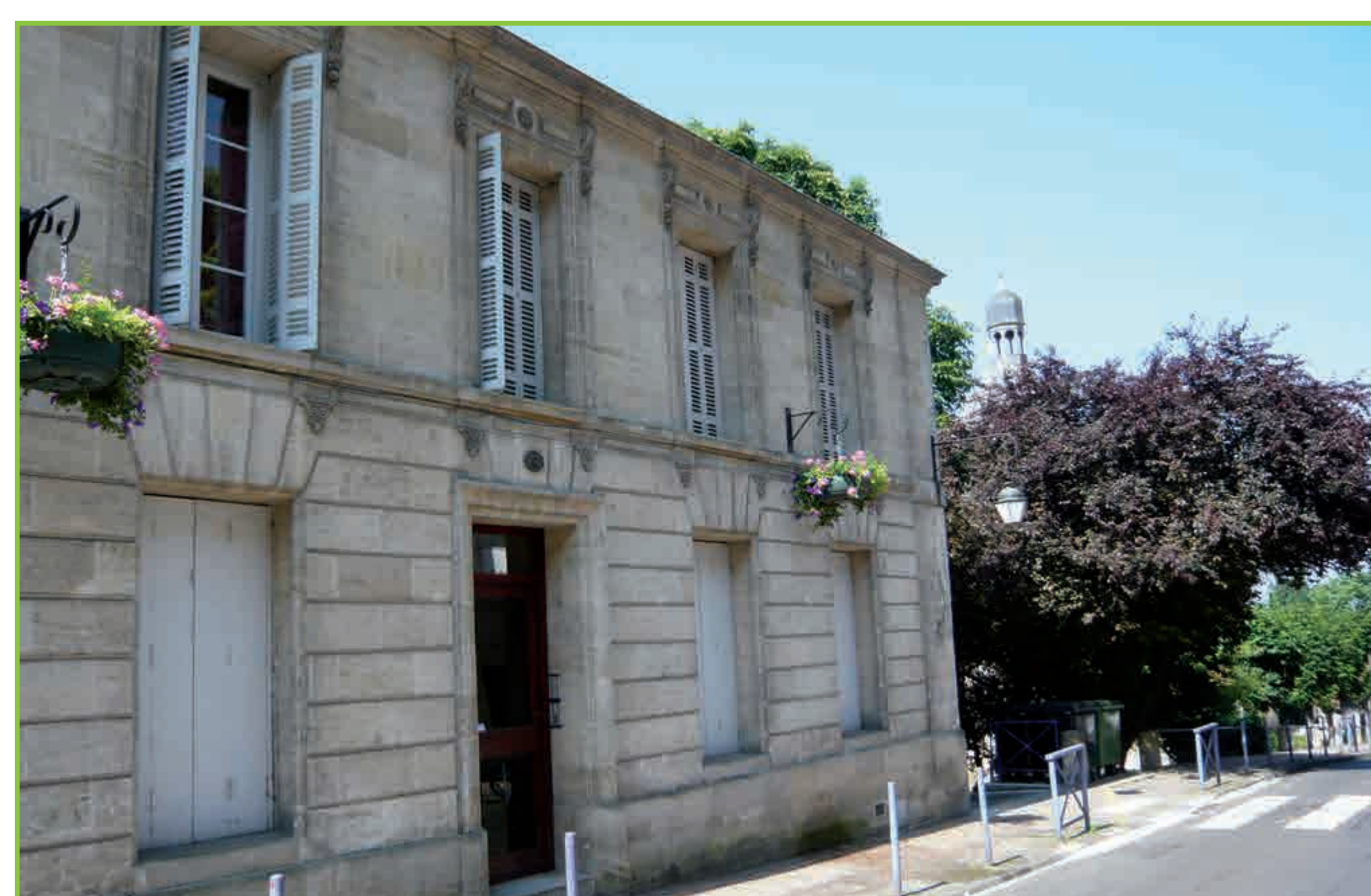
Façade maison en pierre
