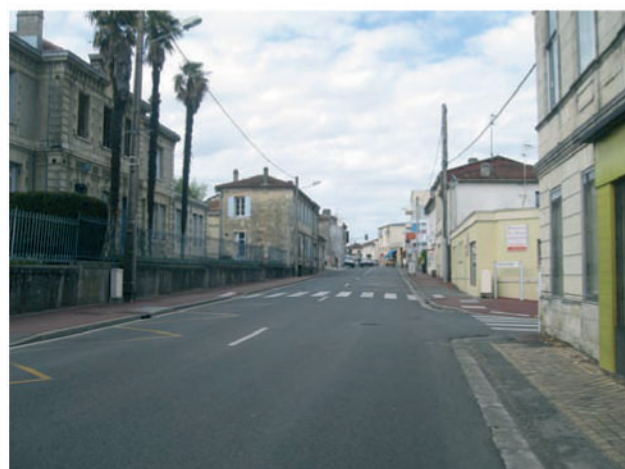
Les fronts bâtis anciens définissent la perception de la voie
