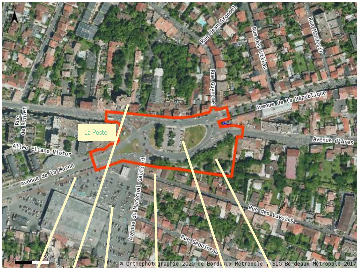
Vue aérienne de la place aujourd'hui. En rouge, le plan du périmètre du projet (Bordeaux est au nord de l'avenue de la République, Mérignac au-dessous)
