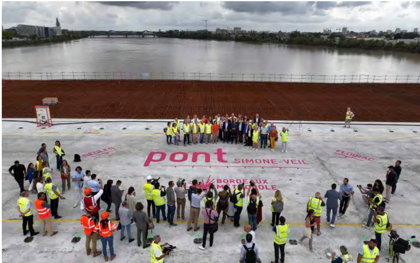
Le fragment manquant : un nouveau boulevard, le boulevard Simon Veil de 545 mètres de long et 44 mètres de large
