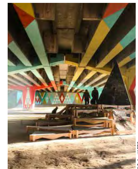
Installations artistiques et sous-faces infrastructurales
