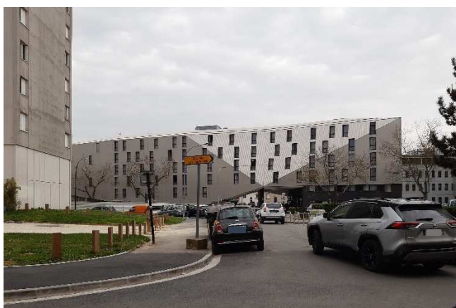
Entrée ancien barreau côté rue Schweitzer, mars 2022
