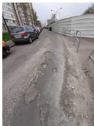
Ancien barreau Schweitzer devant la Résidence Lully
