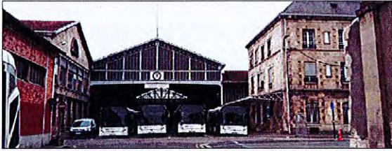
Vue de la travée centrale de la halle
