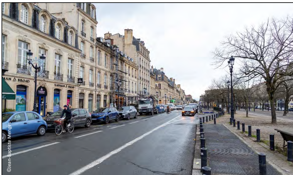
Voie de circulation sur les allées de Tourny avec l'entrée véhicules du parking souterrain
