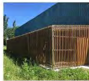
Nouveaux celliers pour chaque logement
