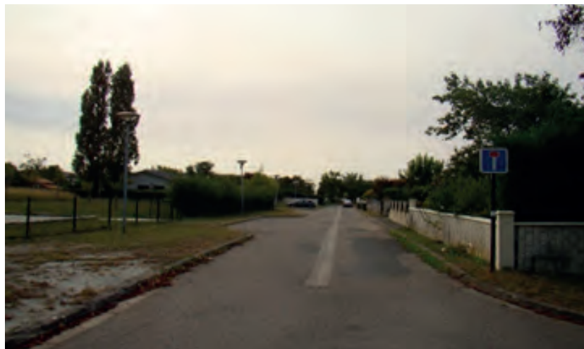
Absence de cheminement piéton le long de l'impasse Cachin
