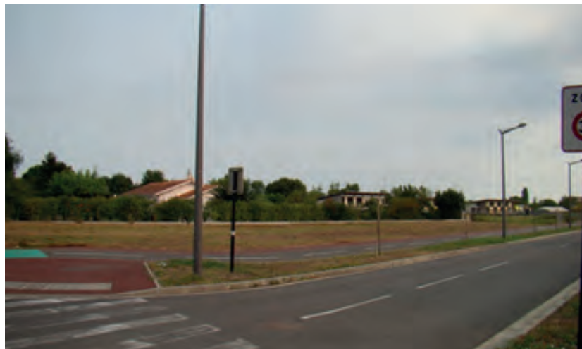
Manque de continuité vers le SO de la piste cyclable aménagée le long de l'avenue du 10 mai 1981
