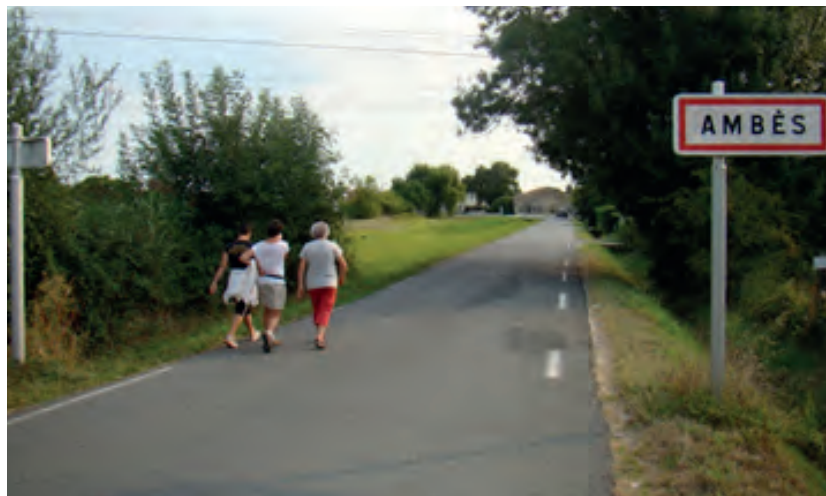
Absence de cheminement piéton le long de la rue des Frères Deves.....
