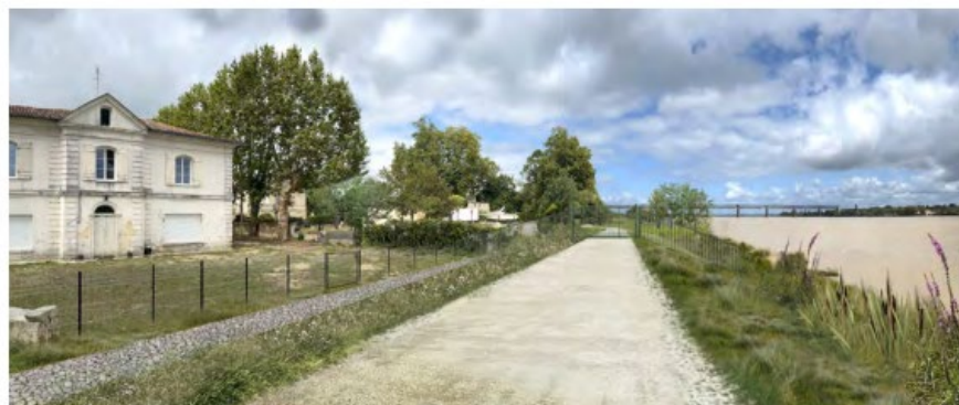
Principe du projet : une digue en remblai de terre (source: CLAP Atelier)
