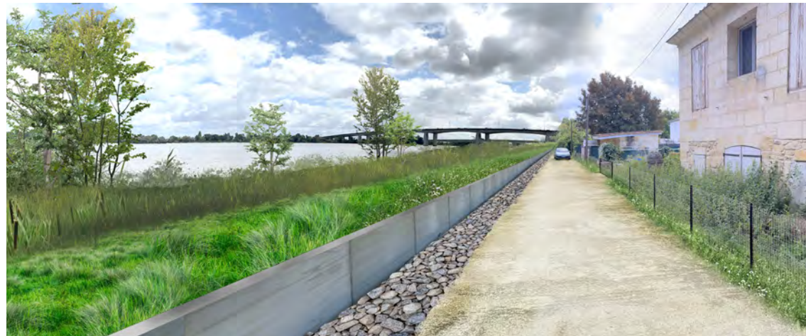
Principe du futur projet: un muret béton épaulé avec un remblai de terre (source: CLAP Atelier)
