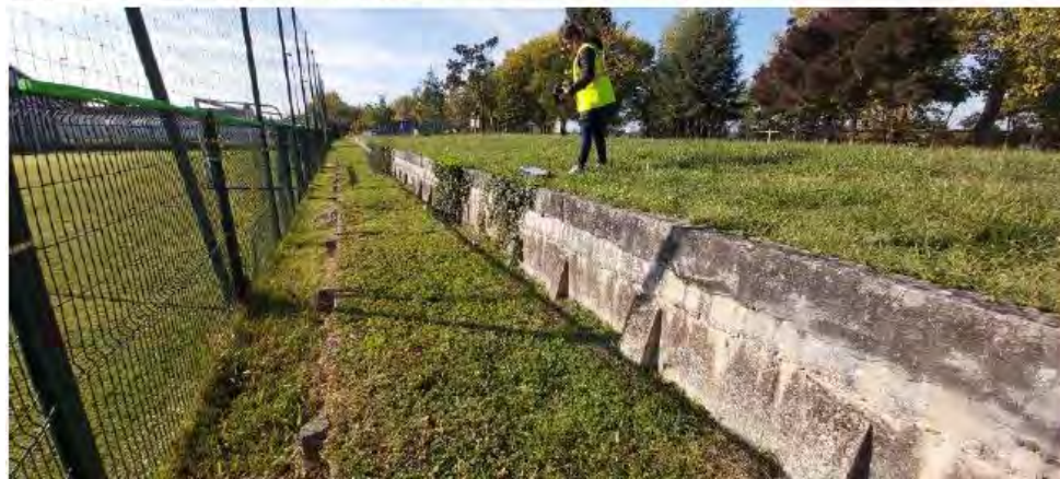
Digue en murette
