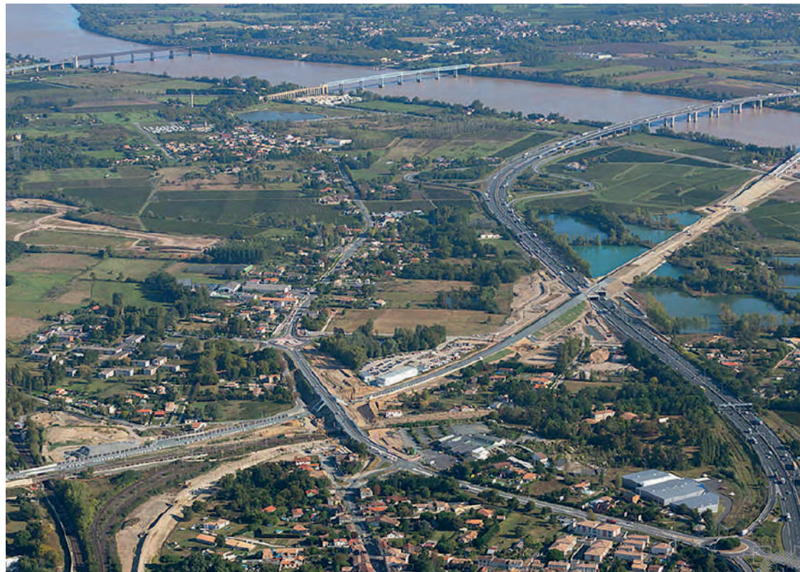
Aménagement de la ligne LGV Paris - Bordeaux, inaugurée en 2017 ©Pascal Ledoare
