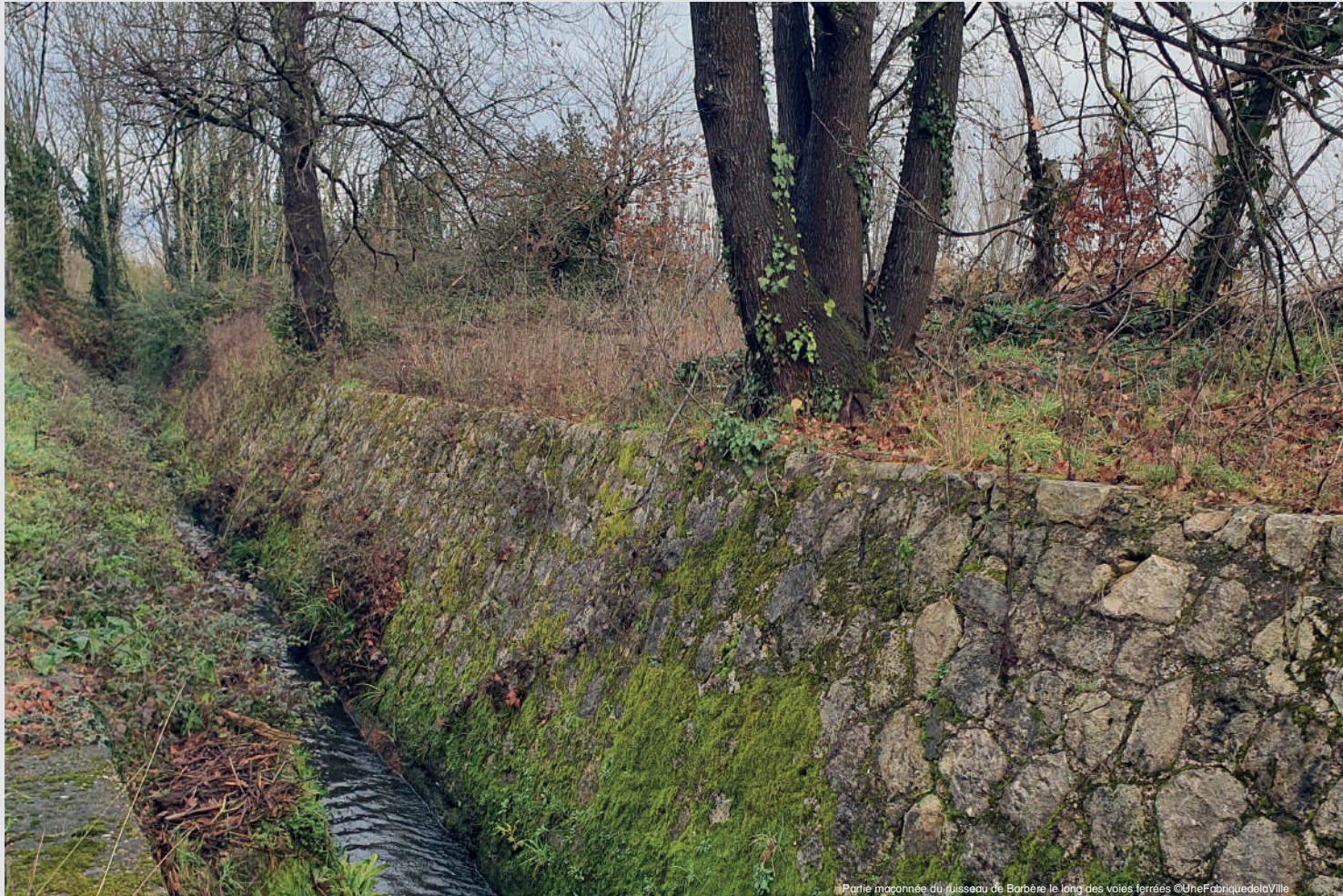
Partie maçonnée du ruisseau de Barbère le long des voies ferrées ©UneFabriqueDeLaVille
