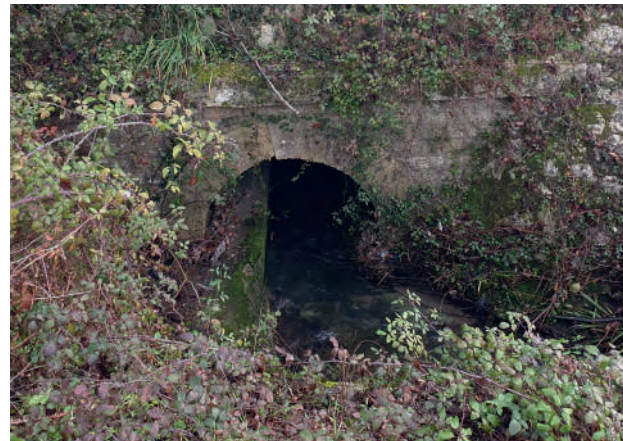
Ruisseau de Barbère devenant souterrain, passant sous les voies ferrées, en direction de l'IRSA.
