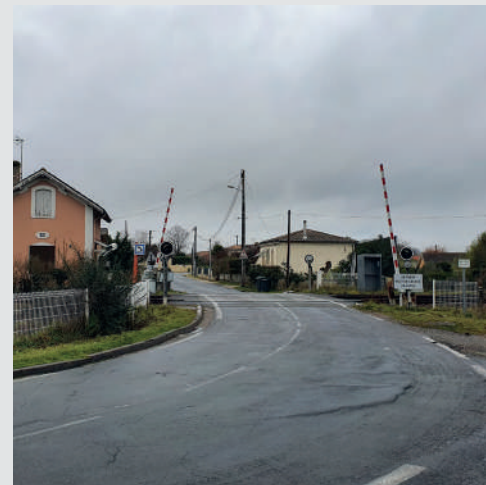
Passage à niveau, rue de Barbère
