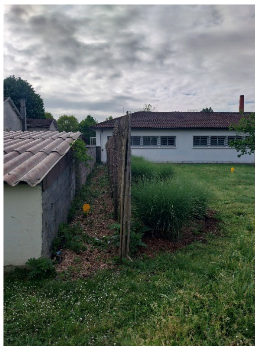
Palissade présente sur l'espace vert
