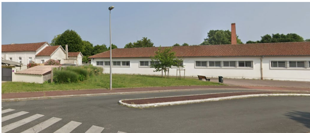
Emprise à déclasser vue de l'avenue de l'Europe : plantations, trottoir, lampadaire, mobilier urbain.
