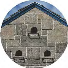
Nichoirs à oiseaux intégrés dans le bâti sous forme de cavités © Urban'Paris
