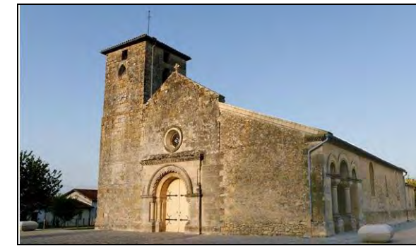
Fig. 73. ÉGLISE DE SAINT-AUBIN (SOURCE : COMMUNE DE SAINT-AUBIN DE MÉDOC)
