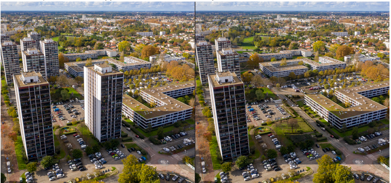
Avant (gauche) / après (droite) démolition des tours, Bordeaux Métropole 2026
