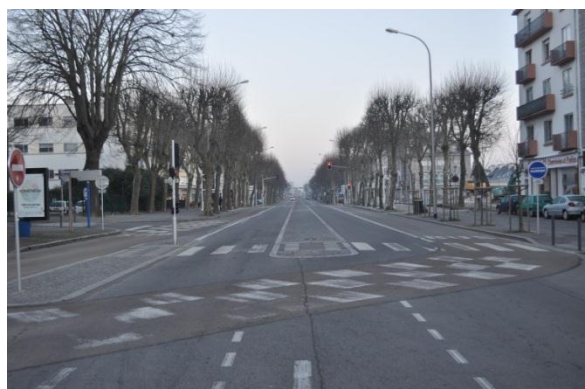
Figure 2 : Lorient, Triskell, vue d'un site propre bilatéral - source : SYSTRA
