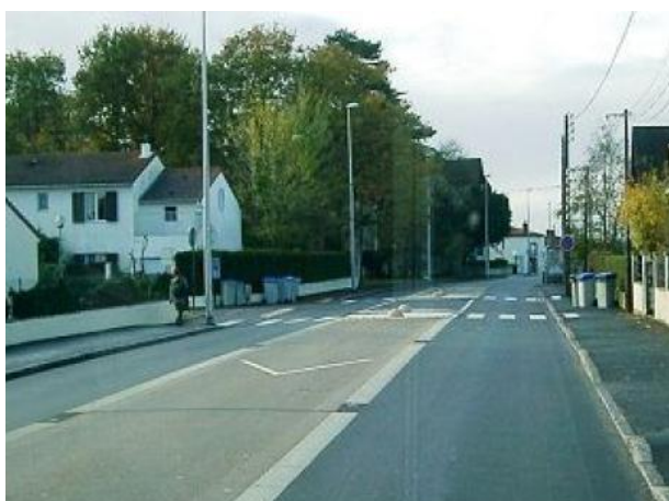
Figure 9 : Nantes, vue d'une voie unique Busway, - source : CERTU
