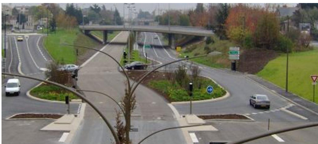
Figure 6 : Nantes, vue de la plateforme Busway - source : CERTU
