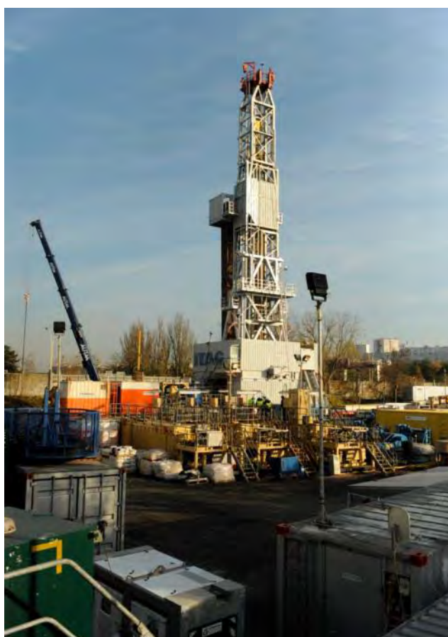
Figure 7 : Machine de forage installée en 2014 sur le puits d'Arcueil (94)
