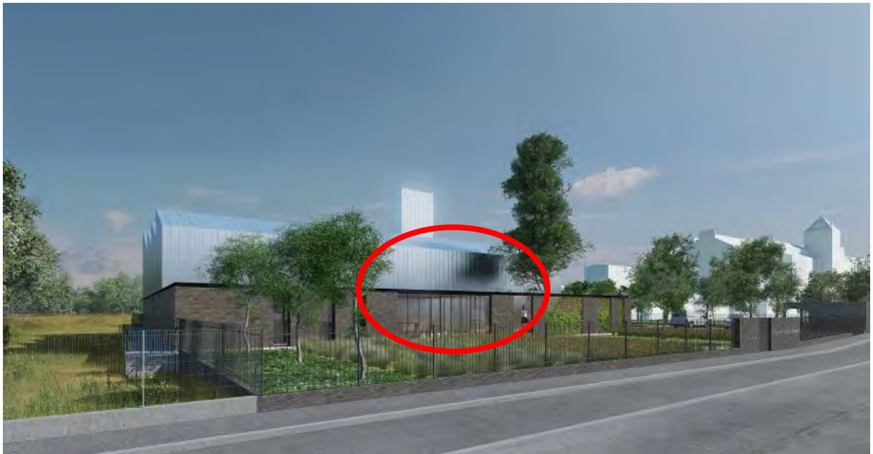
Figure 9 : Maison des énergies citoyennes
