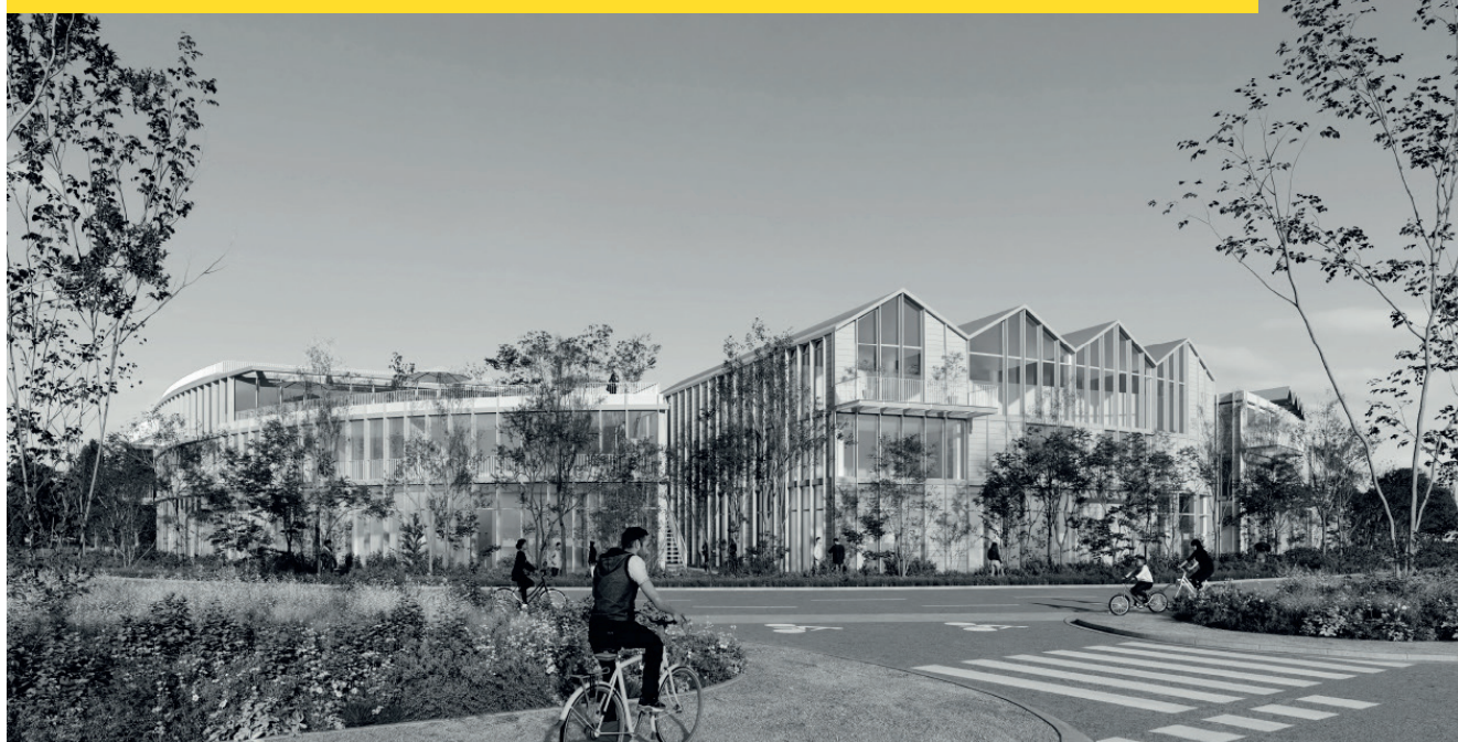
Vue sur les locaux de l'îlot n°1 depuis l'avenue de Terrefort (angle Place du 11 Novembre vers le Nord)
