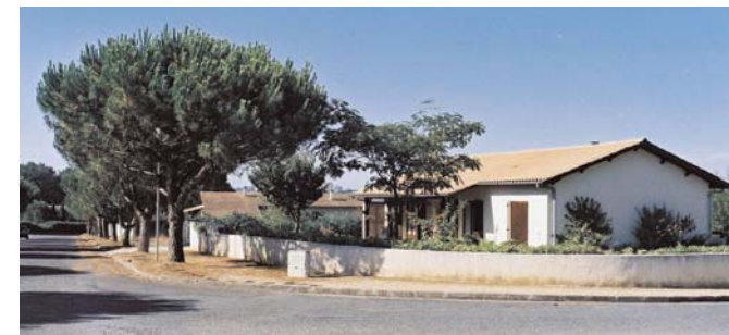
Un lotissement péri-urbain entre 5 et 10 logements/ha
