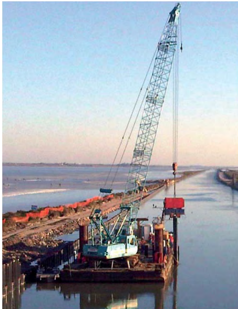
Figure 26 : Exemple de poste de battage depuis une barge – Source : Rapport Général d'Avant-Projet – janvier 2016
