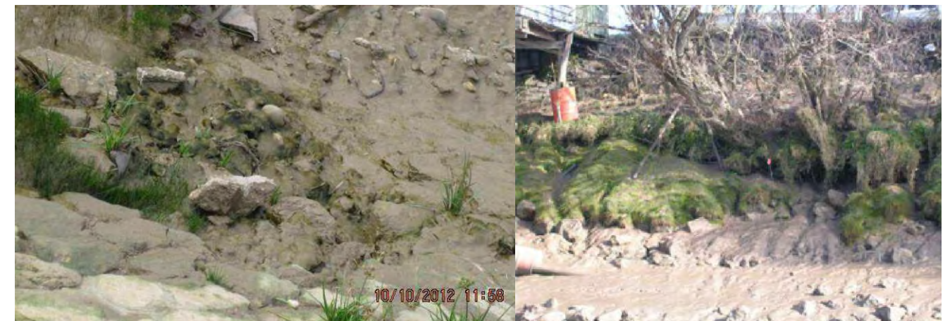
Figure 7 : Déstructuration des perrés – Erosion de berges
