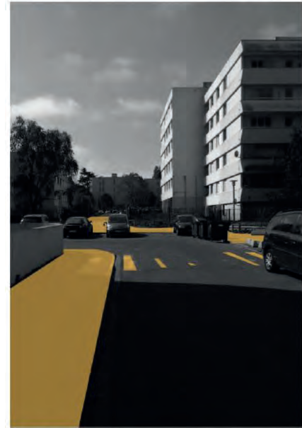
Rue Pétrus Rubens Accès privé envahi par le stationnement, passage piéton détérioré et mauvaise lisibilité du cheminement
