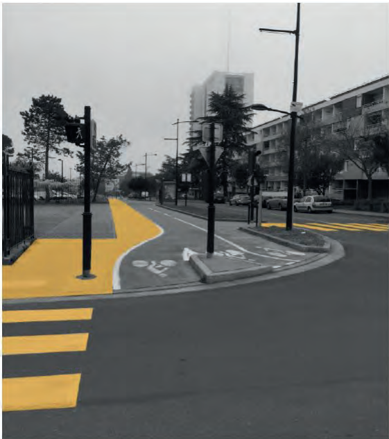
Rue Aristide Briand Poteau empiétant sur l'espace piéton et croisement avec la piste cyclable peu lisible
