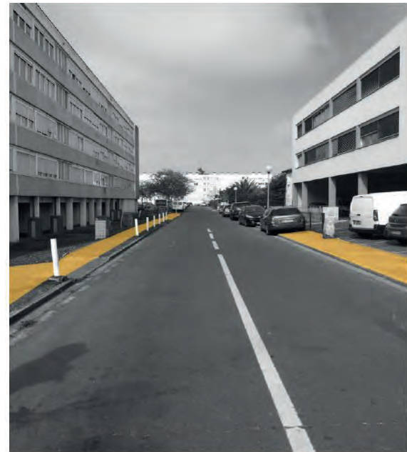
Rue Joachim du Bellay Potelets réduisant l'espace piéton et stationnement sauvage sur les trottoirs
