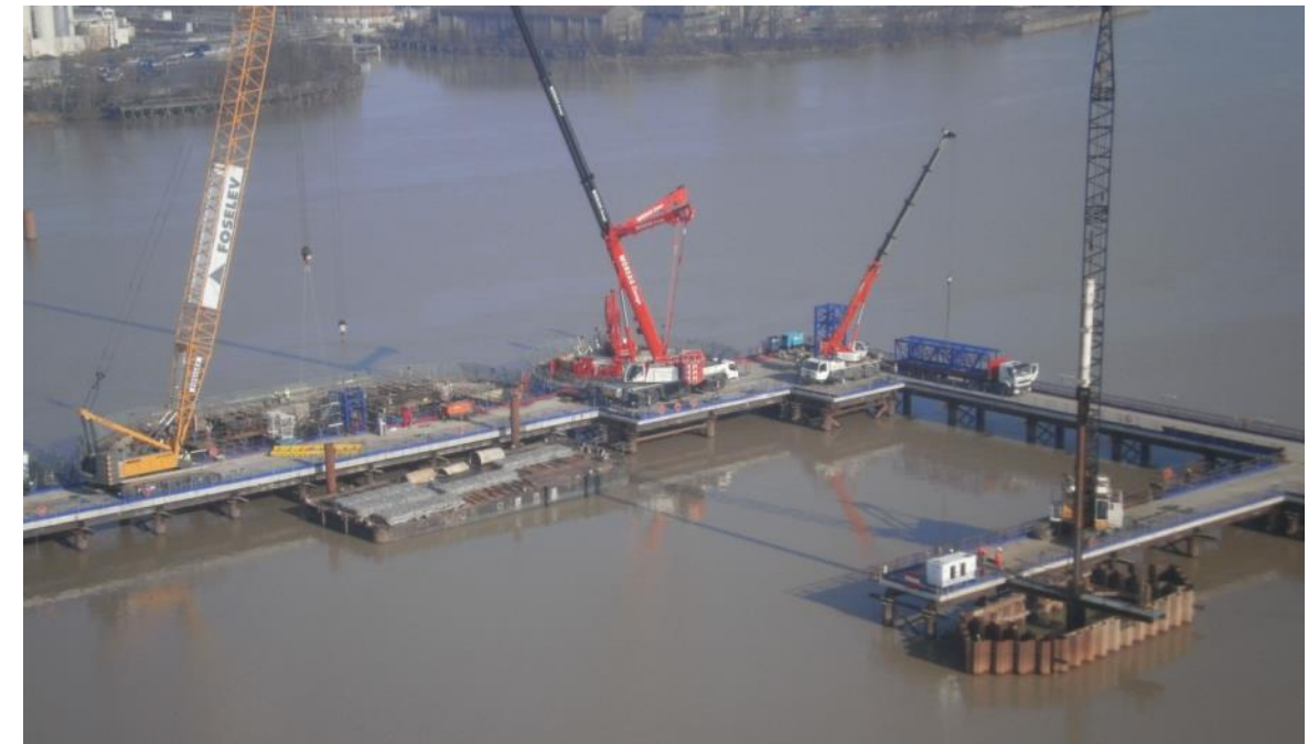
Photographie 20 : travaux en rivière depuis une estacade provisoire (réalisation du Pont Levant à Bordeaux), Egis
