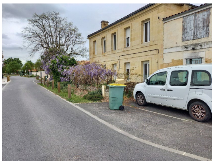
Vue du n°21 après travaux
