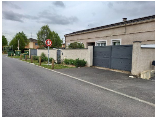
Vue du N° 25 après travaux
