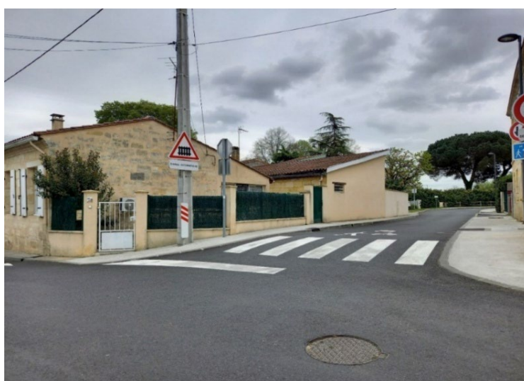
Vues de la rue après les travaux
