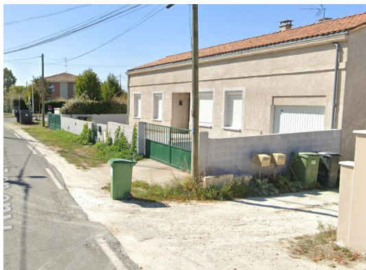
Vue du N° 25 avant travaux
