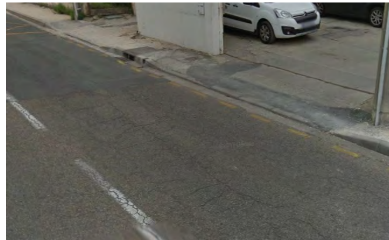
Figure 44: État de la voirie existante
