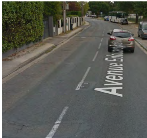
Figure 43: État de la voirie existante
