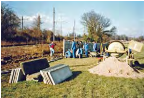
Pose de la clôture le long de la voie ferrée en 2002 (archives municipales)
