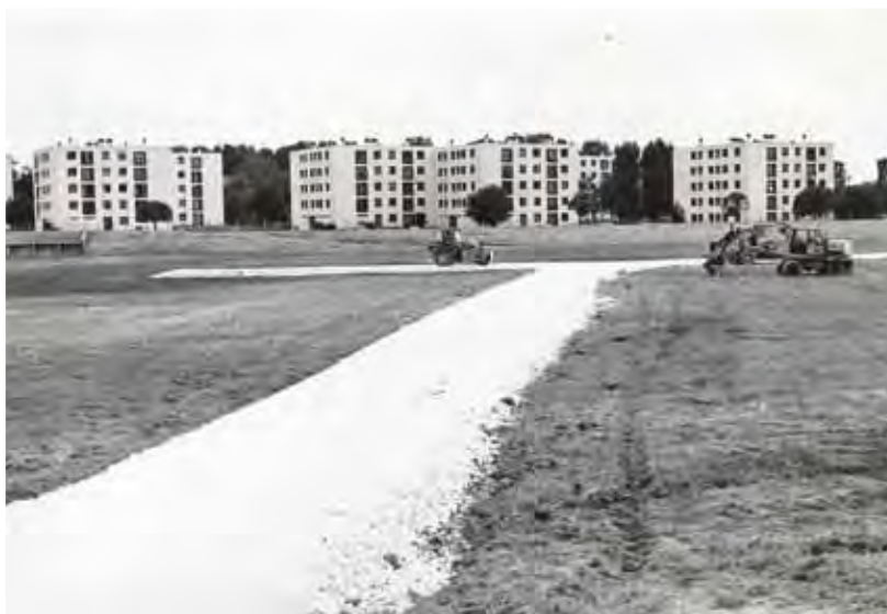
Début du chantier de creusement du bassin Montsouris en 1994 (archives municipales)
