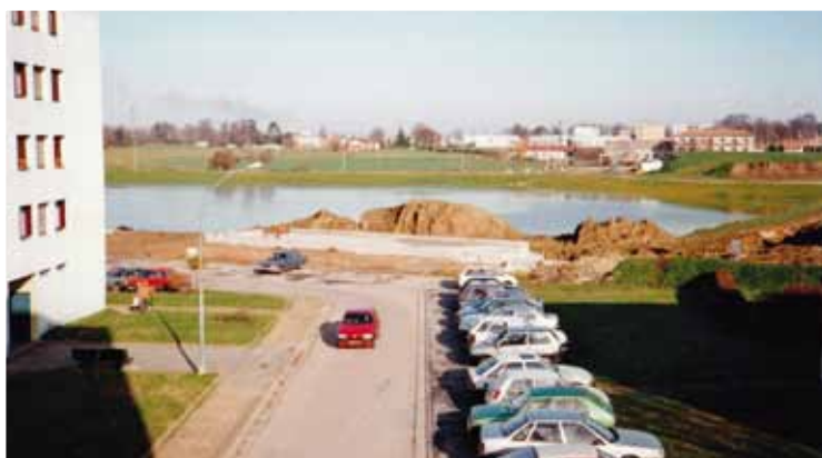
Creusement du bassin Montsouris, avant (1990) et pendant (1992) (collection privée)
